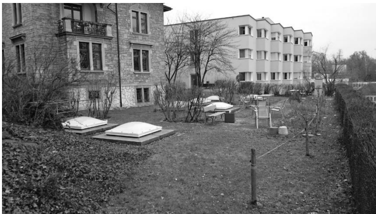
Alter Dachgarten vor der Renovation
